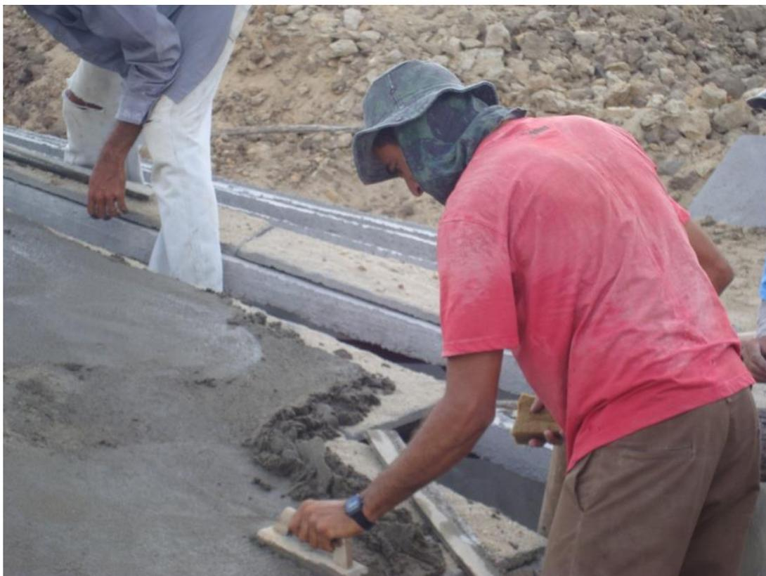
Figura 19: Construção dos decantadores
