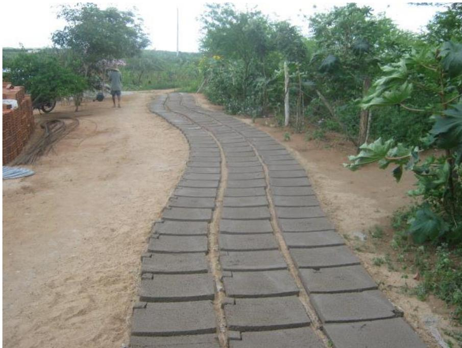
Figuras 6 e 7: Fôrma das 4 diferentes placas da cobertura
