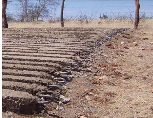
Figura 10: Armadura de ferro da laje do fundo da cisterna
