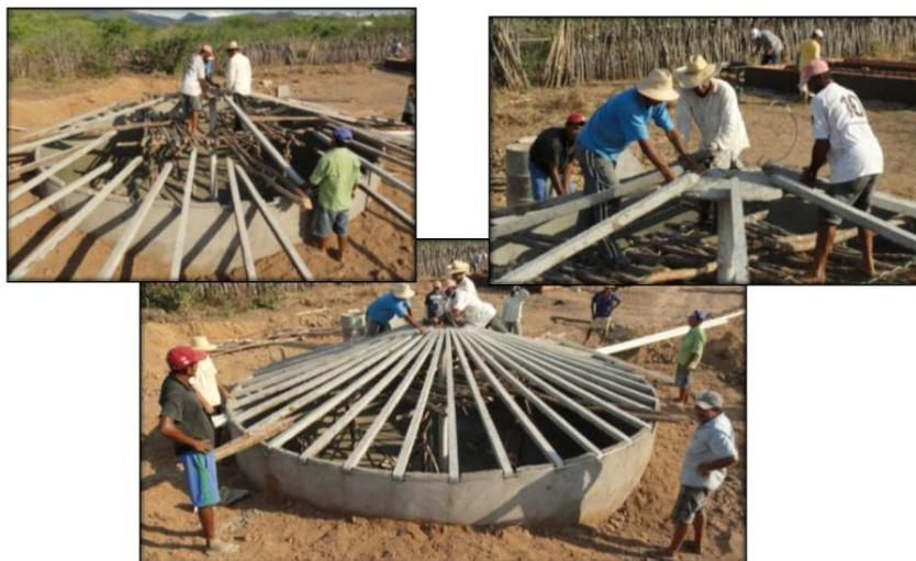
Figura 18: Colocação das Placas da Cobertura
