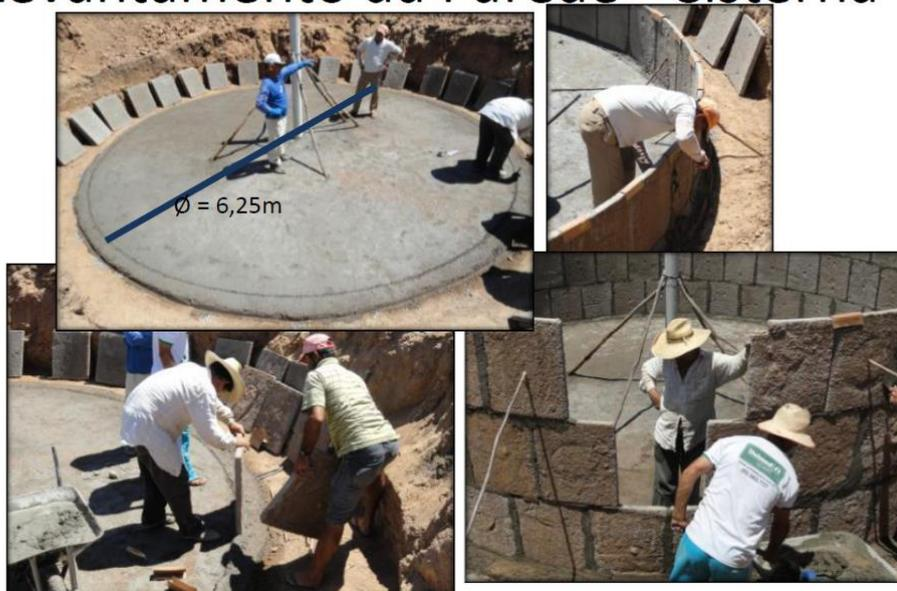
Figura 12: Construção da Coluna Central
