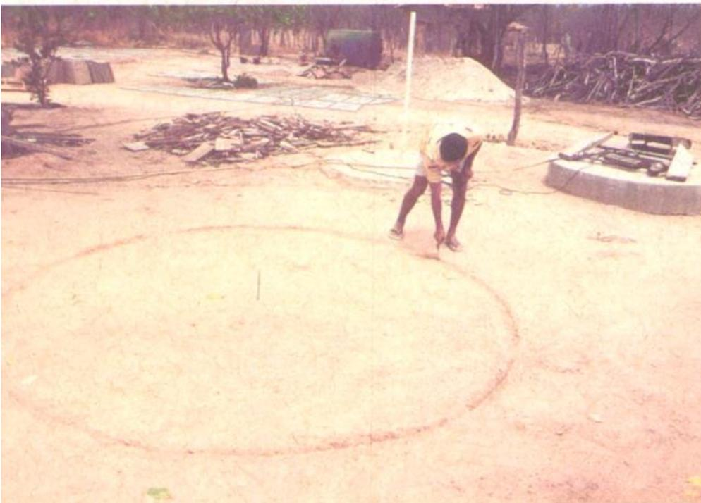
Figura 2: Escavação – não ultrapassar 1,8 m de profundidade
