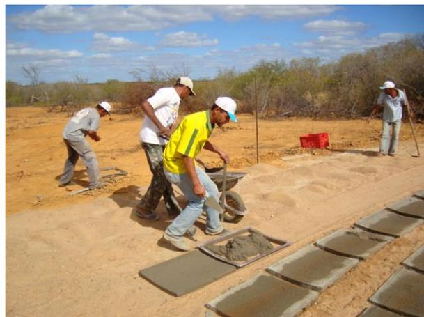
Figura 5: Detalhe das placas com corte para encaixe do caibro
