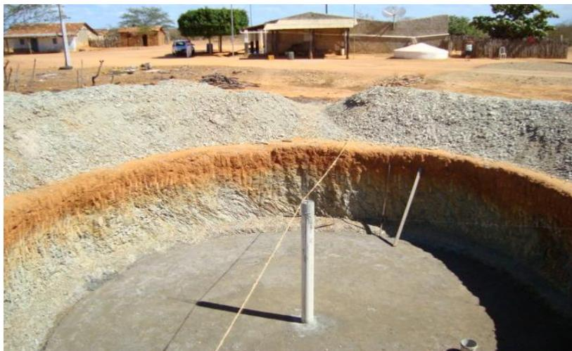
Dentro do cano deve ser colocada 1 barra de ferro CA 50 de 10 mm ( $\frac{3}{8}$ ) com 2,65 m de comprimento, de modo a conferir resistência à coluna. A ferragem vai extrapassar em 20 cm as duas extremidades do cano de PVC para fixação do piso na extremidade inferior e da bandeja na extremidade superior.
