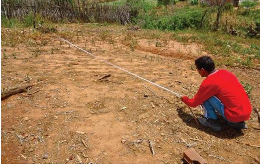
Em seguida, faz-se a marcação dos locais onde serão escavados os buracos com 0,8 m de profundidade para fixação dos 12 pilares de madeira tratada com base na planta baixa (Figura 24).
