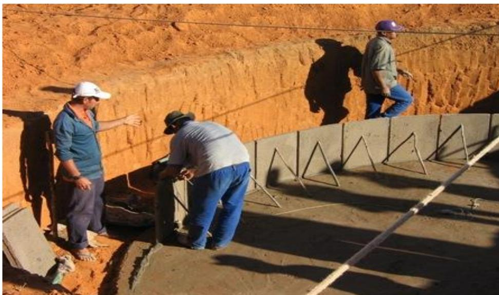
Por fim, as placas devem ser colocadas em “junta amarrada”, em que cada fiada fica defasada meio comprimento da placa em relação à fiada de baixo para facilitar o travamento dos componentes (Figura 16)
