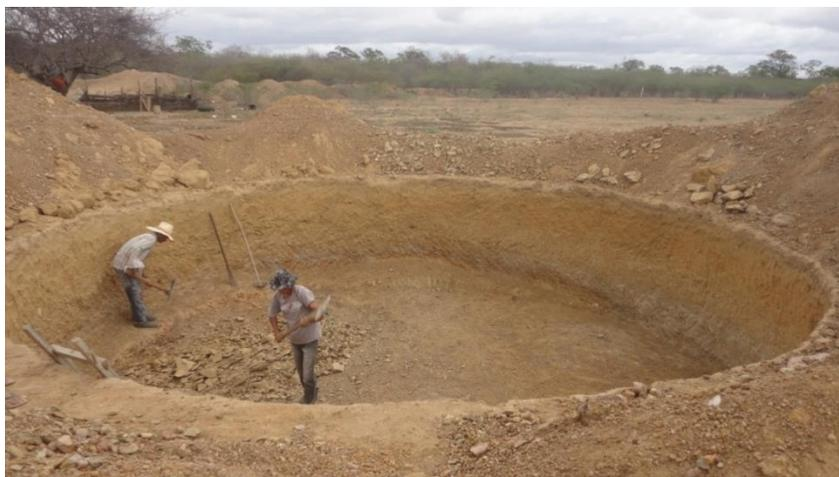
A terra retirada deve ser depositada observando uma distância suficiente para que não desmorone para dentro do buraco, deixando um espaço de pelo 0,5 m em torno da borda da cavidade. Importante que a terra não fique acumulada na área onde vai ser construído o galpão.
