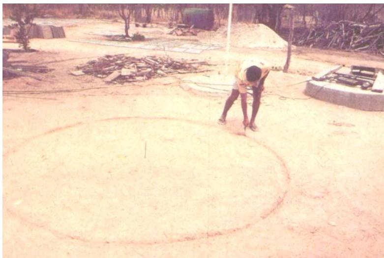
Após da marcação da cisterna, deve ser feita a marcação do galpão. Para tanto, deve ser nivelada uma área de 10 m x 7 m onde serão marcados os locais dos pilares do galpão, de 8 m x 5 m, preferencialmente ao lado da cisterna (Figura 3).
