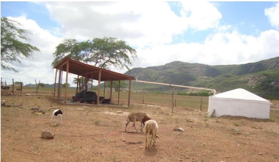
Para a construção do reservatório é necessário realizar inicialmente a escavação de um buraco, pois a cisterna precisa ficar parcialmente enterrada para dar sustentabilidade à sua parede. A parede e a cobertura são construídas com placas de concreto pré-moldado e, para a execução do piso, utiliza-se uma malha de ferro para reforçar o concreto.
