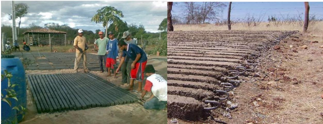
Verifica-se que a barra de ferro excede o comprimento do caibro em 0,10 m. Esse excedente deve ser dobrado em 0,05 m, formando um gancho que deve ficar fora da forma, conforme pode ser observado na Figura 10.
