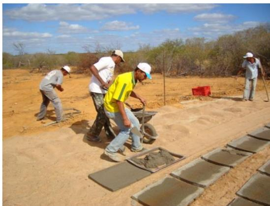
Para a construção da parede da cisterna são necessárias 78 placas, sendo 52 inteiriças e 26 com um corte de 10 x 10 cm no canto superior esquerdo.
