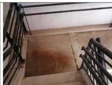
Foto 28 - Centro de Tênis – parte interna da torre de acesso com patamares das escadas comprometidos.
