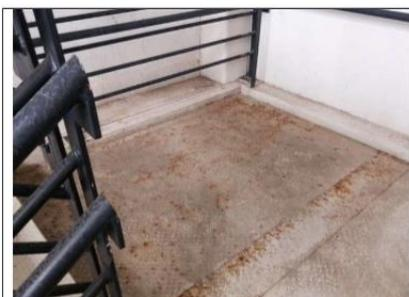
Foto 27 – Centro de Tênis – parte interna da torre de acesso com patamares das escadas comprometidos.
