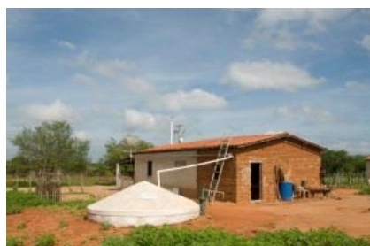
Cisterna de placas de 16 mil litros
