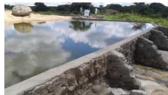
Tanque de Pedra
