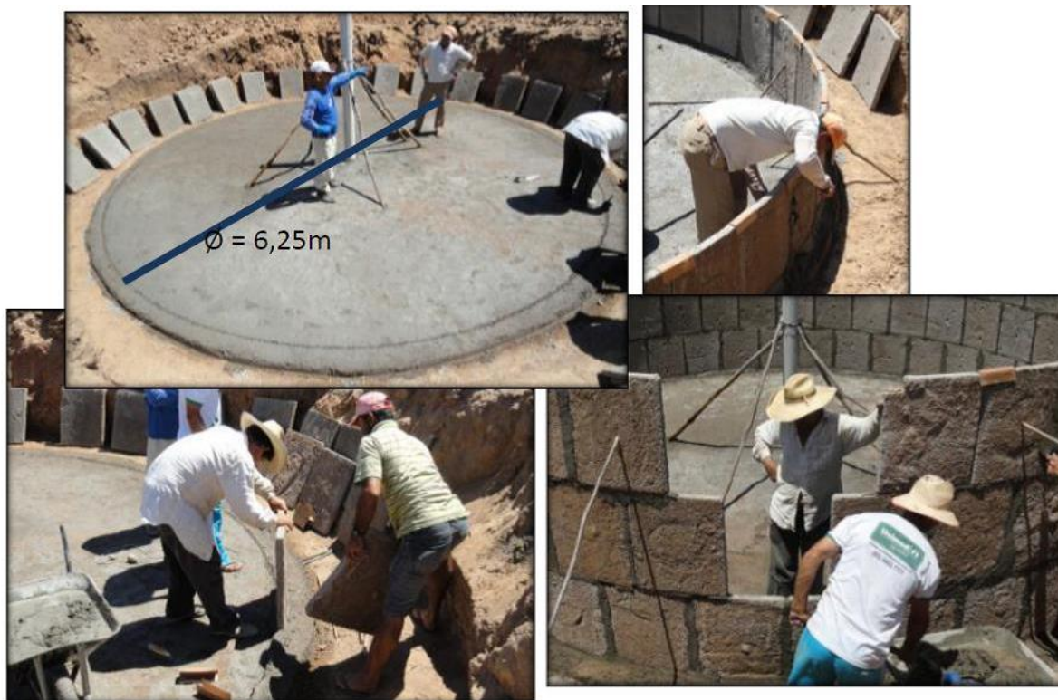
Figura 9: Construção da Parede da Cisterna
