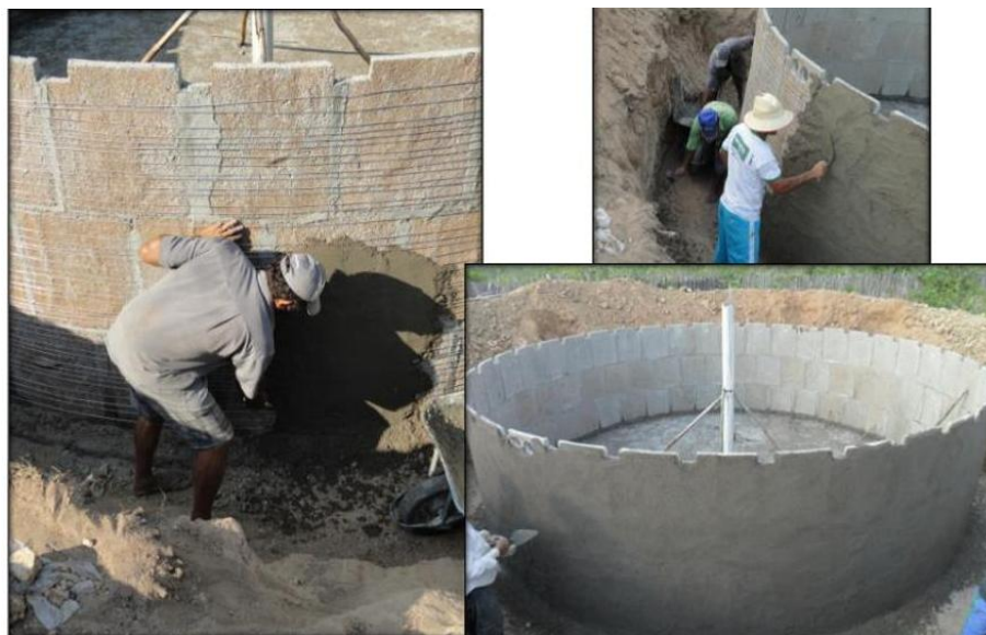
Figura 13: Reboco externo da cisterna
