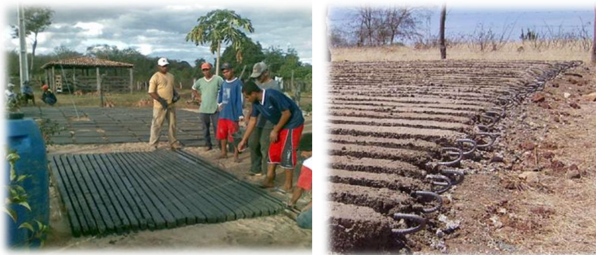
Figura 7: Confeção dos caibros da cobertura da cisterna
