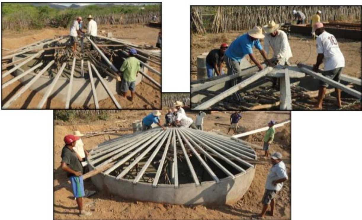
Figura 15: Colocação dos caibros
