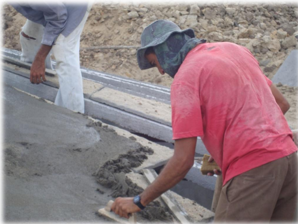
Figura 16: Colocação das Placas da Cobertura
