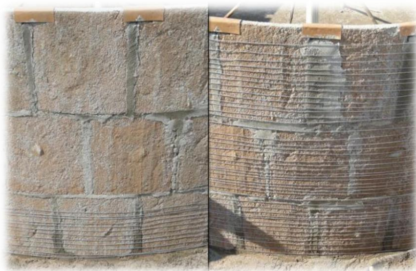
Figura 12: Amarração da parede da cisterna
