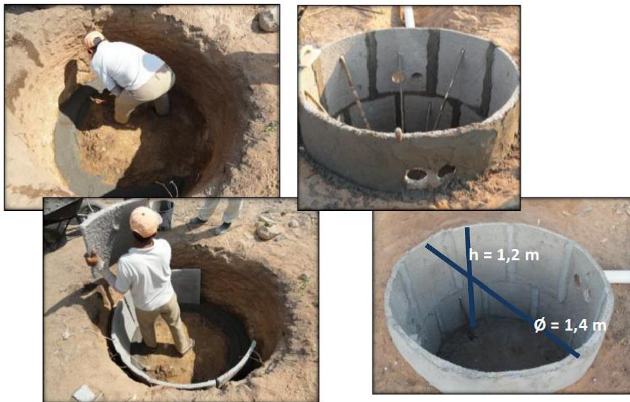
Figura 17: Construção dos decantadores
