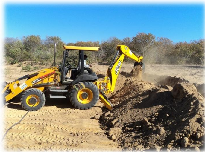
Figura 2: Escavação com retroescavadeira
