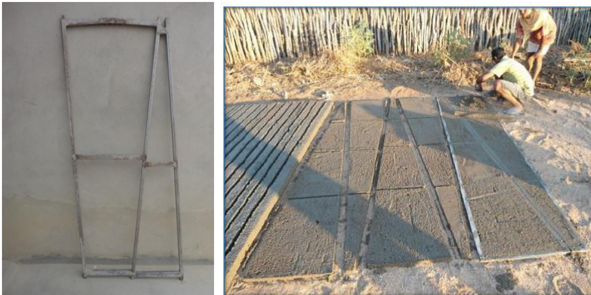
Figura 6: Fôrmas das 4 diferentes placas da cobertura da cisterna
