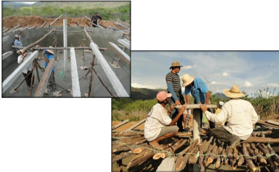
Figura 14: Colocação da Coroa
