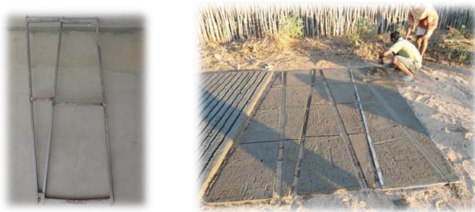
Figura 7. Fôrma das 4 diferentes placas da cobertura da cisterna
