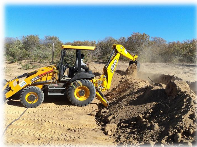
Figura 4. Escavação - não ultrapassar 1,8 m de profundidade
