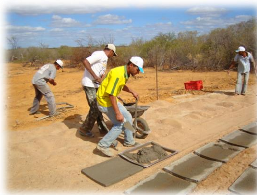
Figura 6. Dimensões e confeção das placas da parede da cisterna
