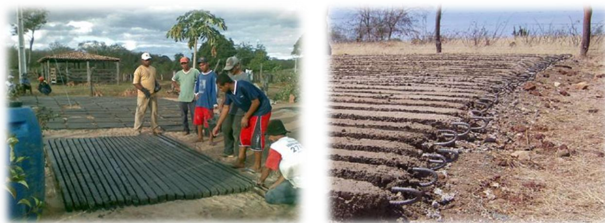
Figura 8. Confeção dos caibros da cobertura da cisterna
