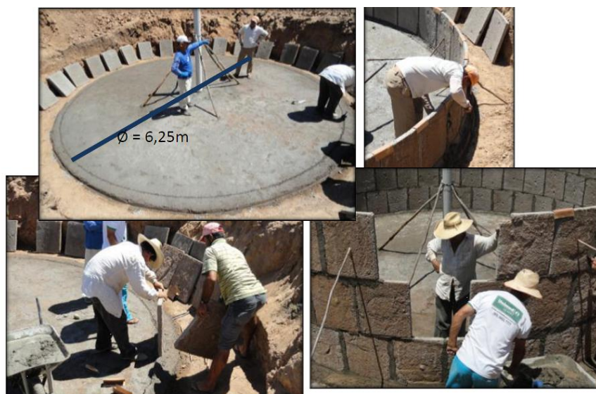
Figura 10. Construção da parede da cisterna
