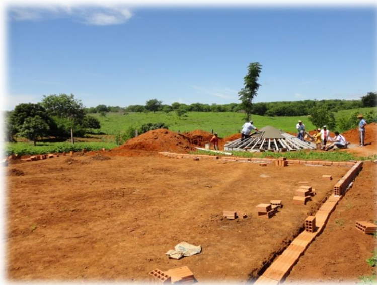
Figura 16. Construção do Calçadão
