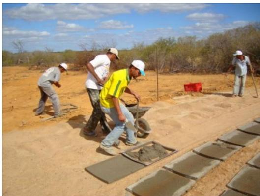
Para a construção da parede da cisterna são necessárias 78 placas, sendo 52 inteiriças e 26 com um corte de 10 x 10 cm no canto superior esquerdo.
