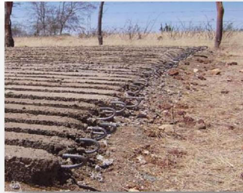
Verifica-se que a barra de ferro excede o comprimento do caibro em 0,10 m. Esse excedente deve ser dobrado em 0,05 m, formando um gancho que deve ficar fora da forma, conforme pode ser observado na Figura 10.
