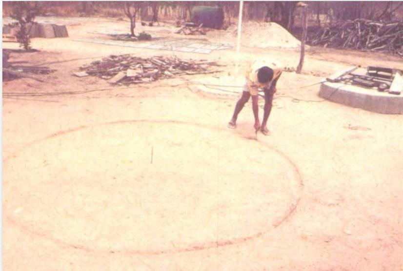
Após da marcação da cisterna, deve ser feita a marcação do galpão. Para tanto, dever ser nivelada uma área de 10 m x 7 m onde serão marcados os locais dos pilares do galpão, de 8 m x 5 m, preferencialmente ao lado da cisterna (Figura 3).
