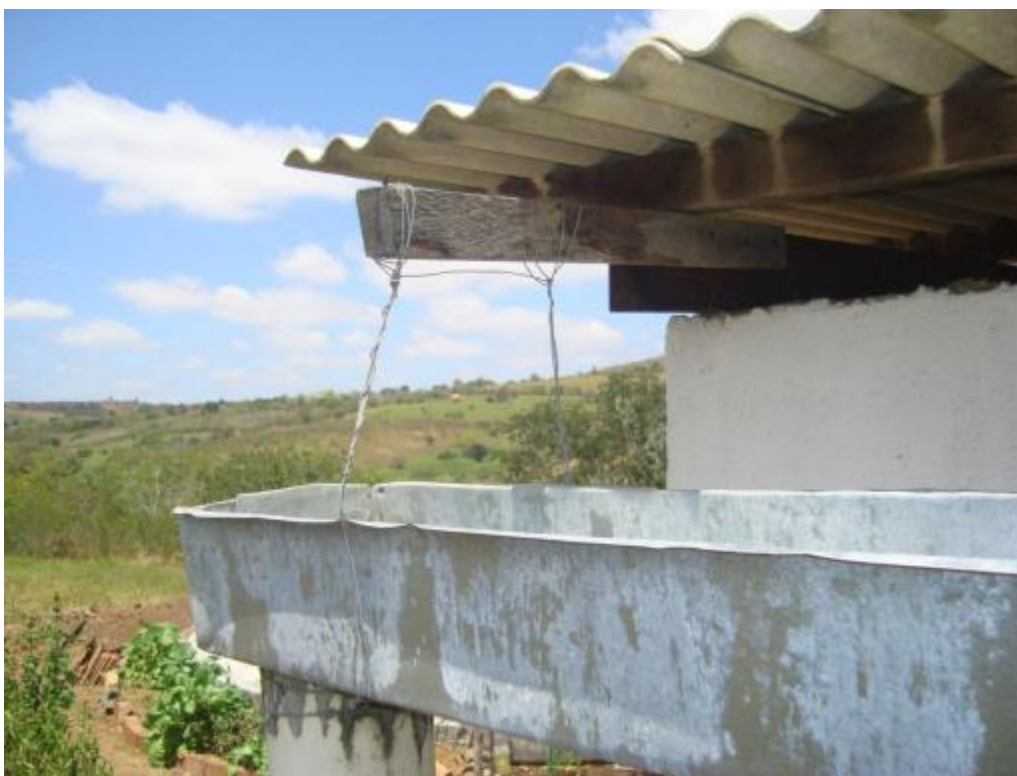
Figura 28 – Fixação da Calha
