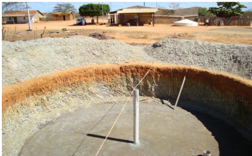
Figura 17 – Fixação da coluna central
