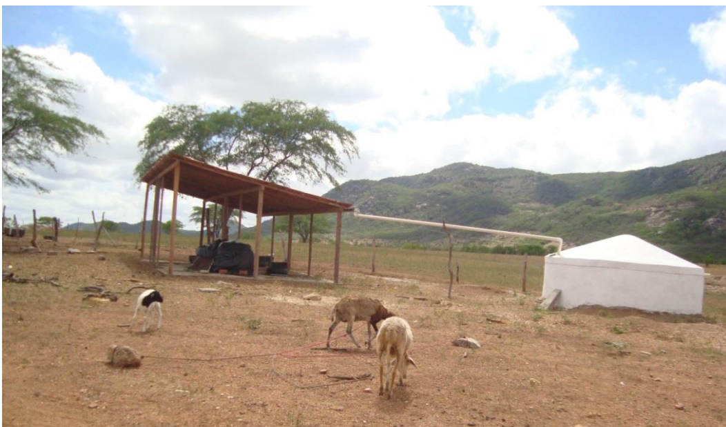
Figura 1 – Foto ilustrativa da cisterna telhadão (conjunto galpão e cisterna)
