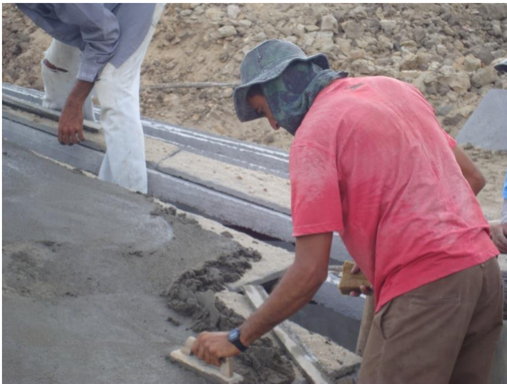
Figura 22 – Colocação das placas e reboco da cobertura
