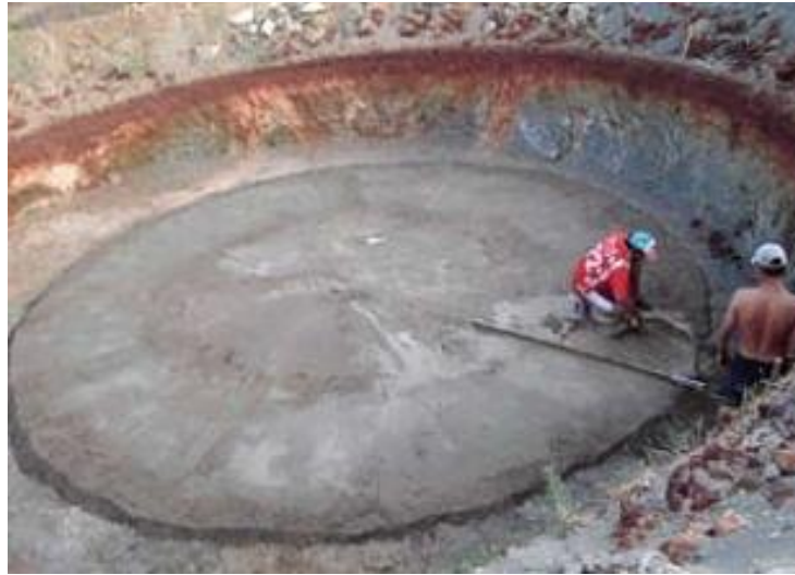
Figura 12 – Execução da laje do fundo da cisterna
