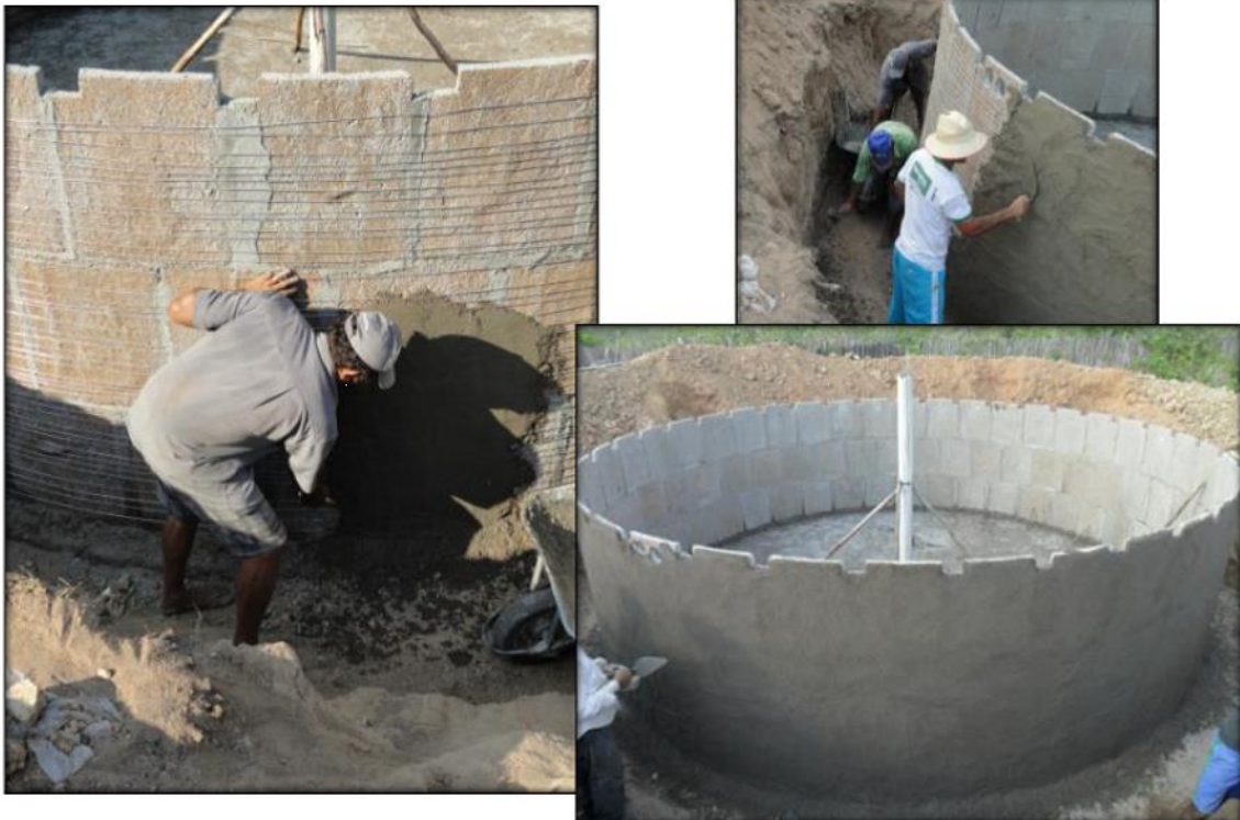
Figura 19 – Procedimentos do reboco externo
