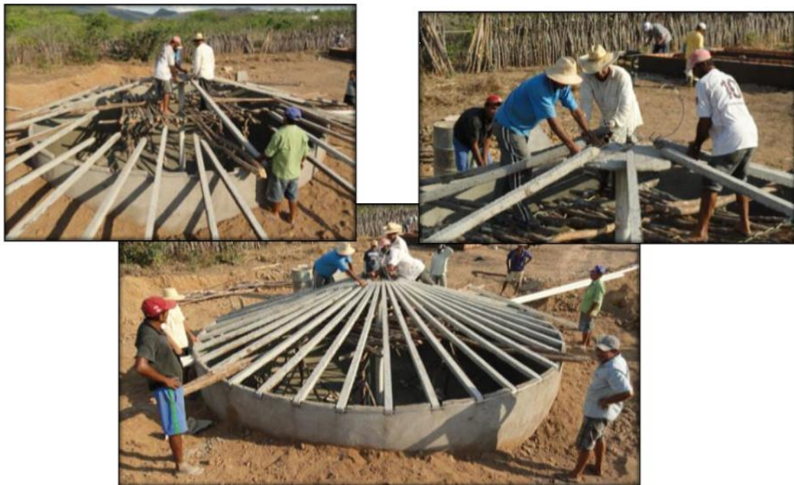
Figura 21 – Colocação dos caibros e amarração sobre a coroa
