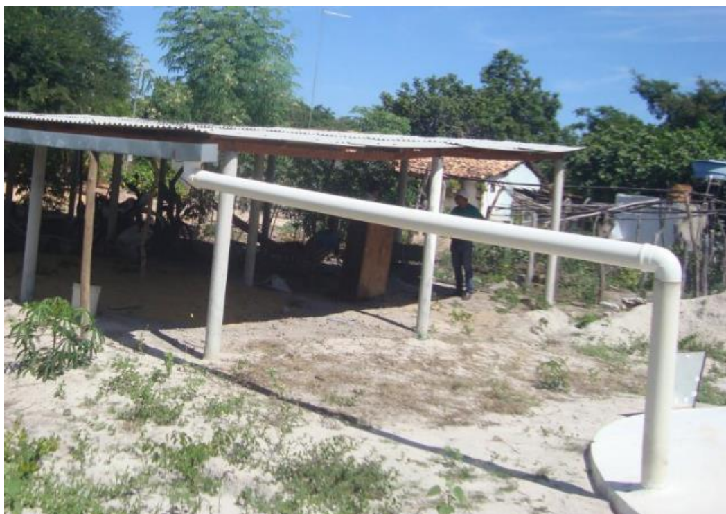
Figura 29 – Conexão da calha à cisterna
