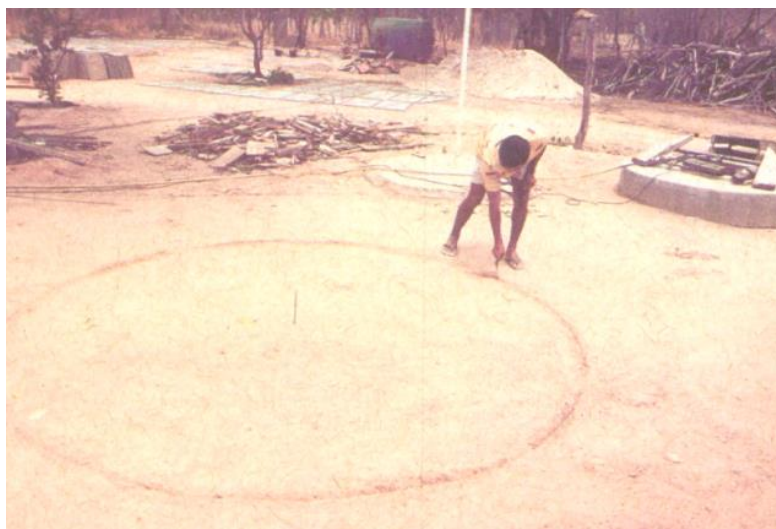
Figura 2 - Marcação da cisterna
