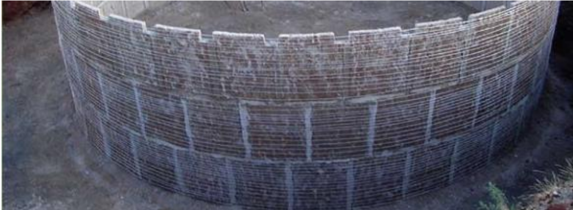
Figura 16 – Assentamento e amarração da placas com arame, sendo a última fieira com os cortes para encaixe dos caibros
