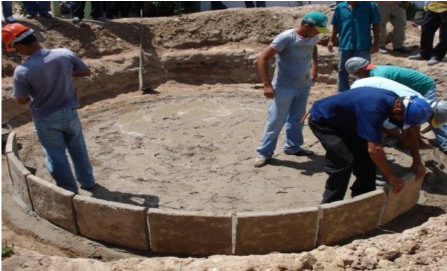
Figura 14 – marcação da parede
