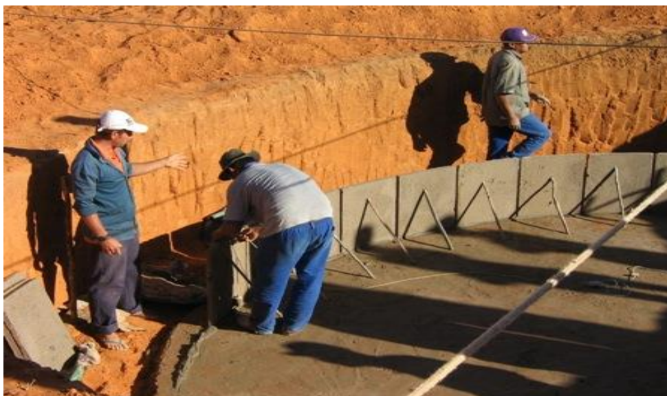
Figura 15 – Escoramento das placas com varetas
