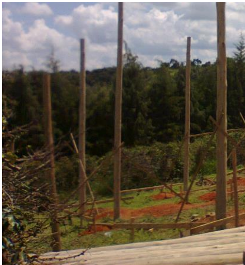
Figura 27 – Fixação dos pilares
