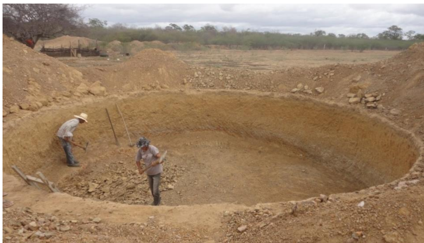
Figura 4 – O fundo do buraco deve ser nivelado com ferramentas manuais.
