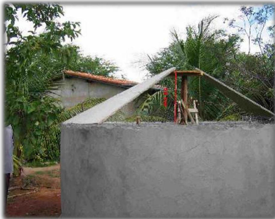
Para apoiar provisoriamente as placas da cobertura, instalar no cento da cisterna um suporte de madeira, com 2,5 m colocando em sua extremidade superior um disco de madeira com 60 cm de diâmetro, com resistência suficiente para suportar o peso de 20 placas.
