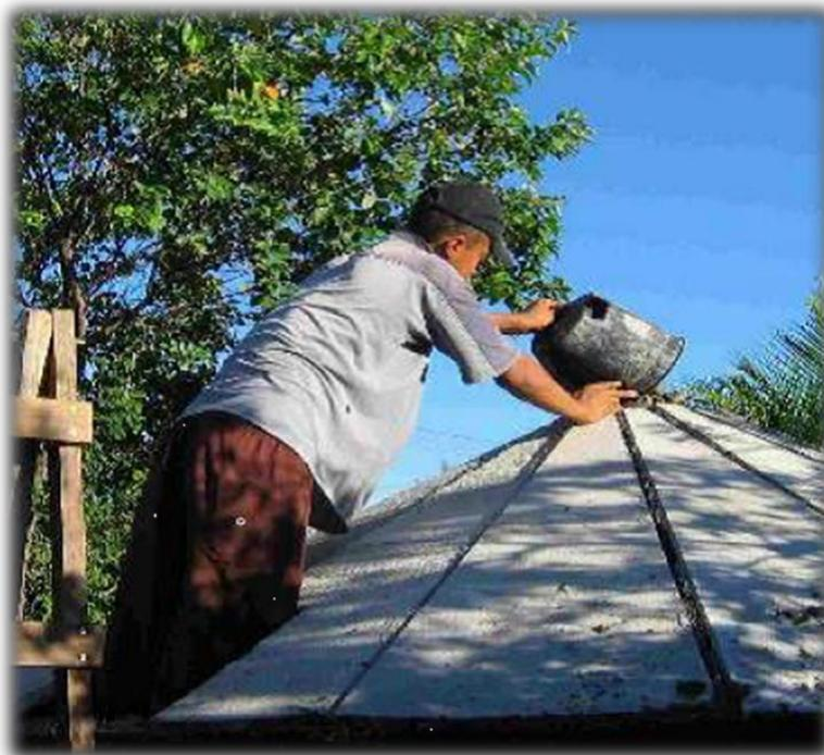
O vão acima do disco de madeira, na junção das placas, deve ser preenchido com argamassa com o mesmo traço das paredes. Preencher também o vão entre as placas.
