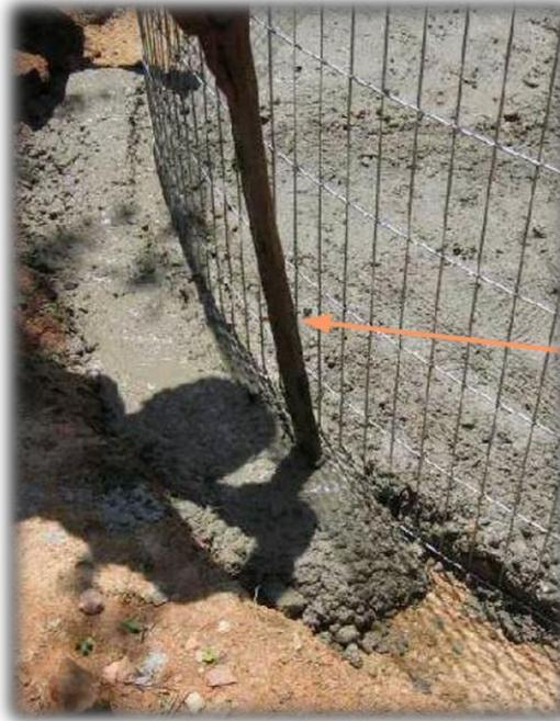
Para manter o formato do cilindro de tela de alambrado e para não deformar quando da aplicação da primeira camada de argamassa, é necessária a colocação de escoras com 1 m de distância uma da outra, conforme ilustrado abaixo.
