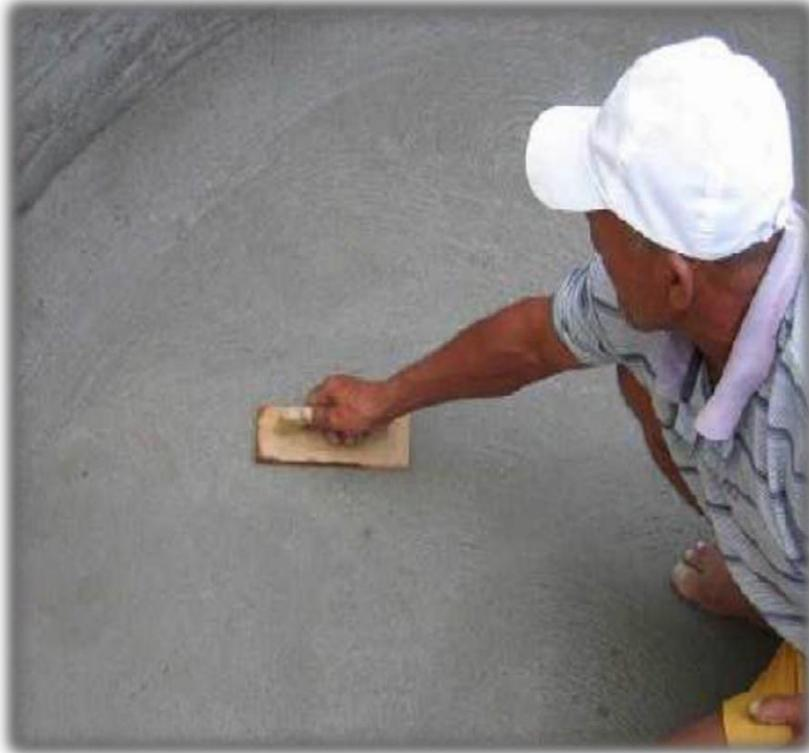
Para o acabamento do piso, aplicar uma camada de argamassa com 2 cm sobre o contrapiso armado. A junção da parede com o piso deve ser feita em “meia lua”. No dia seguinte, aplicar uma camada de “nata de cimento” para selar os poros.
