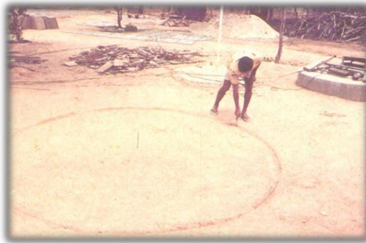
Após da marcação da cisterna, deve ser feita a marcação do galpão. Para tanto, dever ser nivelada uma área de 10 m x 12 m onde serão marcados os locais dos pilares do galpão, de 8 m x 10 m, preferencialmente ao lado da cisterna (Figura 2).
