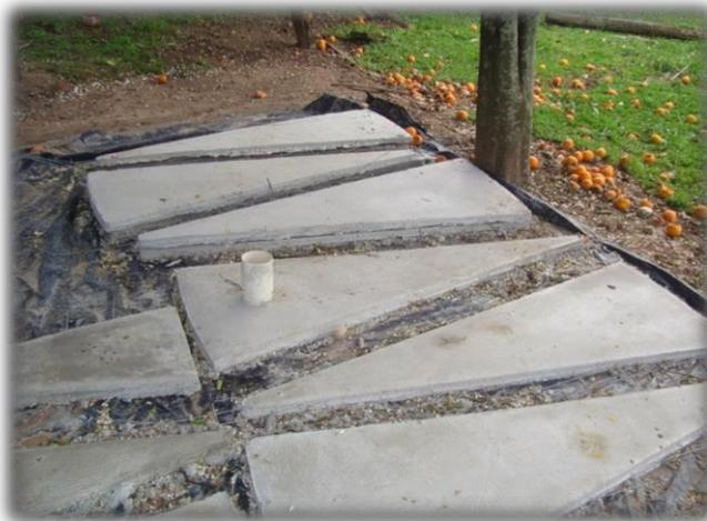
Uma das placas deve ser preenchida pela metade, apenas o lado da “ponta”, de modo a deixar uma abertura na cobertura da cisterna, onde deverá ser instalada uma tampa.
