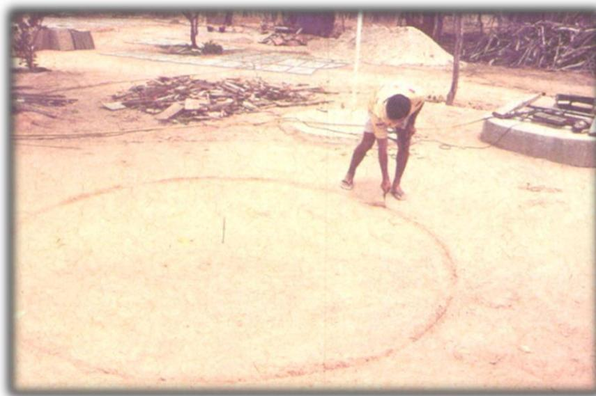
Após da marcação da cisterna, deve ser feita a marcação do galpão. Para tanto, deve ser nivelada uma área de 10 m x 12 m onde serão marcados os locais dos pilares do galpão, de 8 m x 10 m, preferencialmente ao lado da cisterna (Figura 2).
