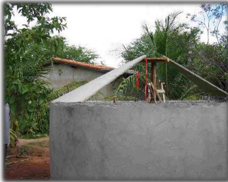
Para apoiar provisoriamente as placas da cobertura, instalar no cento da cisterna um suporte de madeira, com 2,5 m, colocando em sua extremidade superior um disco de madeira com 60 cm de diâmetro, com resistência suficiente para suportar o peso de 16 placas, conforme ilustrado abaixo.
