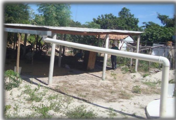
Conexão da calha à cisterna
