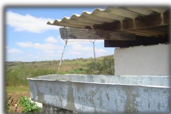
Junto ao sistema de captação deve ser incluído dispositivo para descarte automático das primeiras águas da chuva, com vistas à proteção da qualidade da água captada e armazenada, conforme orientações apresentadas no item II.
