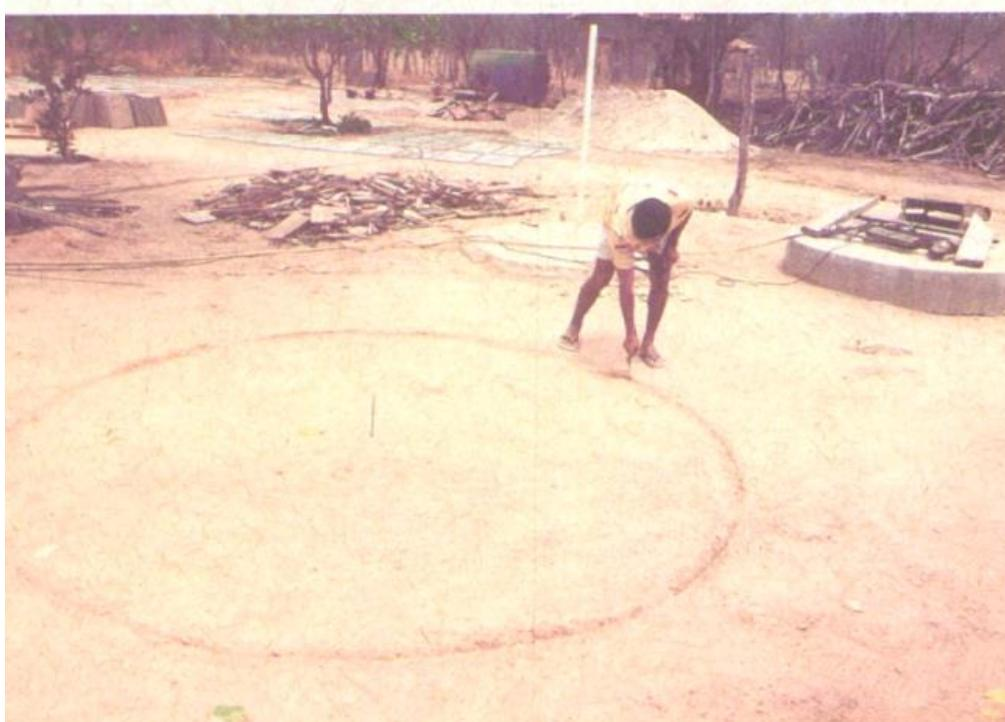
**Figura 4.** Escavação - não ultrapassar 1,8 m de profundidade
