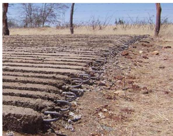
**Figura 12.** – Armadura de ferro da laje do fundo da cisterna
