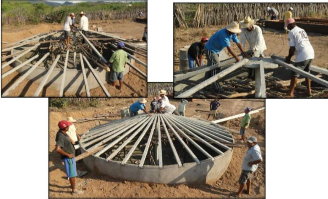
**Figura 18.** Colocação das placas de cobertura
