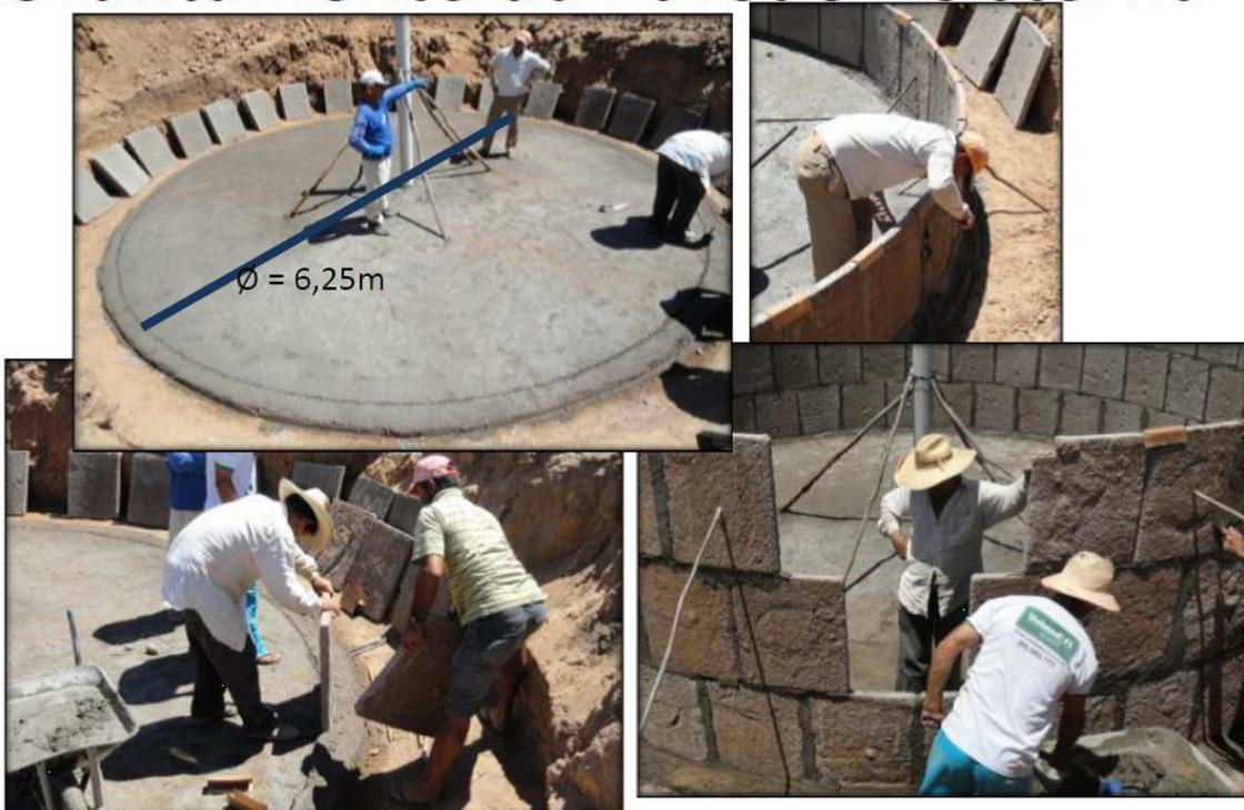
**Figura 14.** Construção da coluna Central
