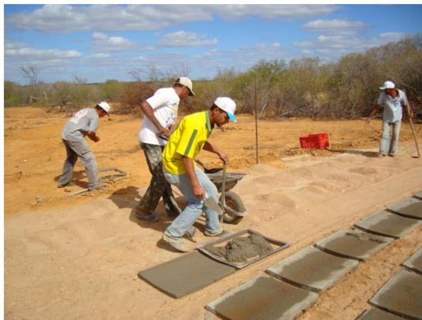
**Figuras 8 e 9 – Fôrma das 4 diferentes placas da cobertura da cisterna**
