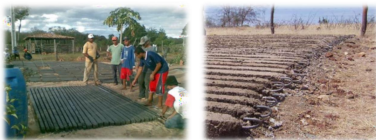
Figura 8. Confecção dos caibros da cobertura da cisterna
