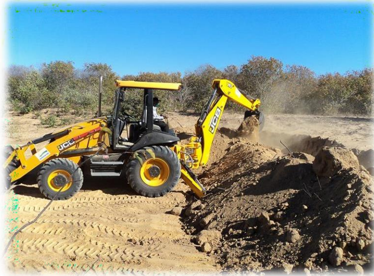
Figura 4. Escavação - não ultrapassar 1,8 m de profundidade
