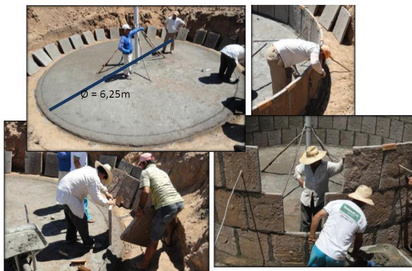
Figura 10. Construção da parede da cisterna
