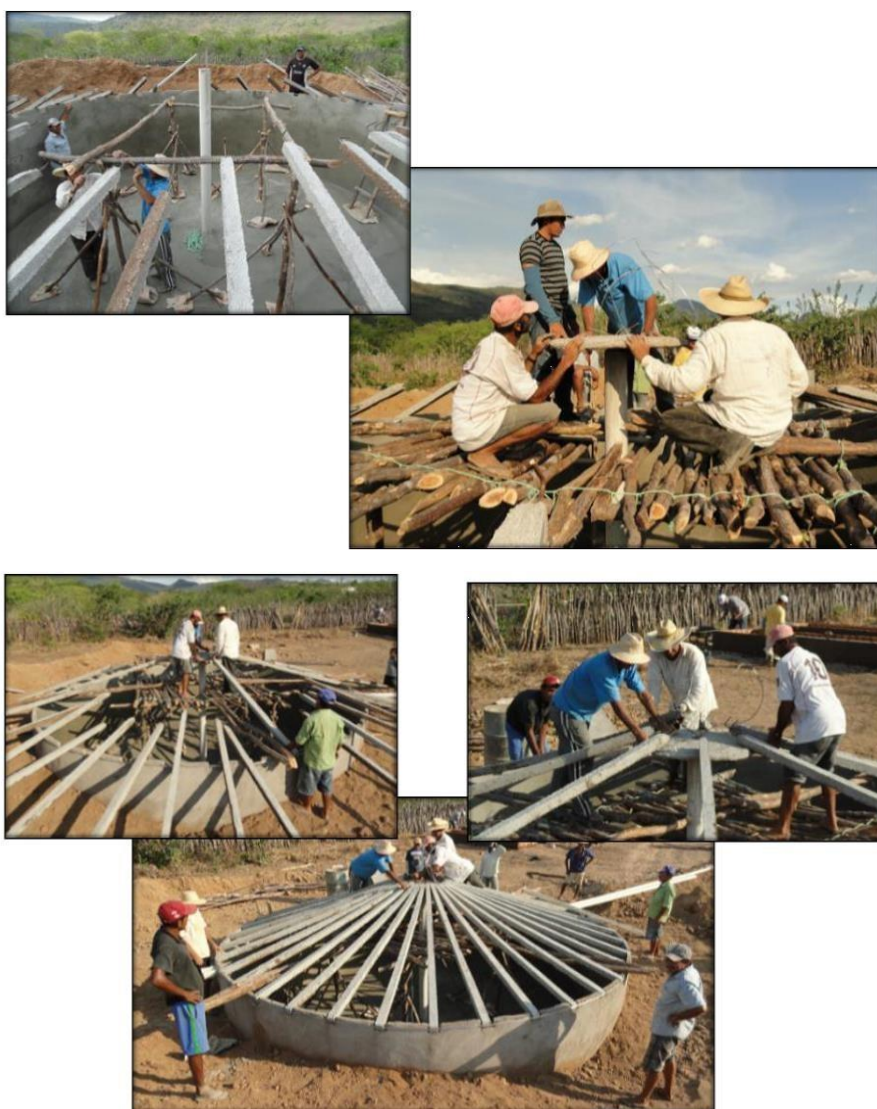
Figura 14. Colocação da coroa e dos caibros
