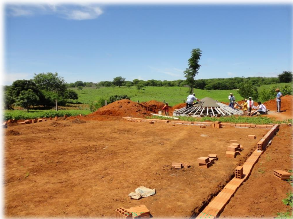
Figura 16. Construção do Calçadão
