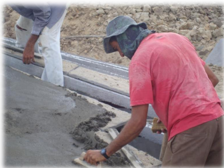
Figura 15. Colocação das placas de cobertura
