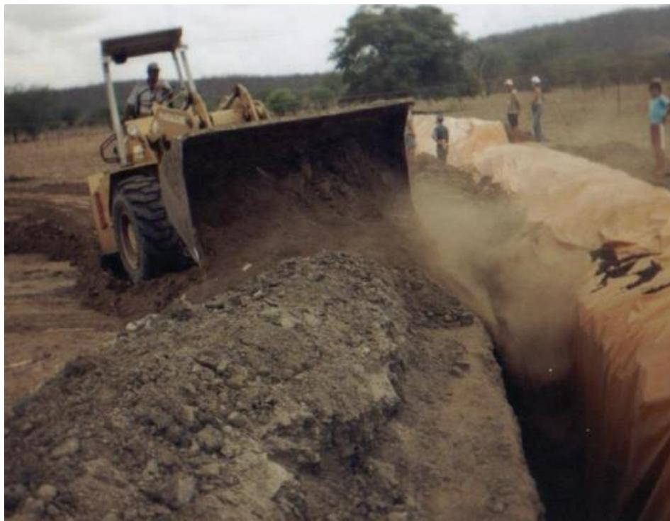
Figura 11: Construção do vertedouro (sangradouro)
