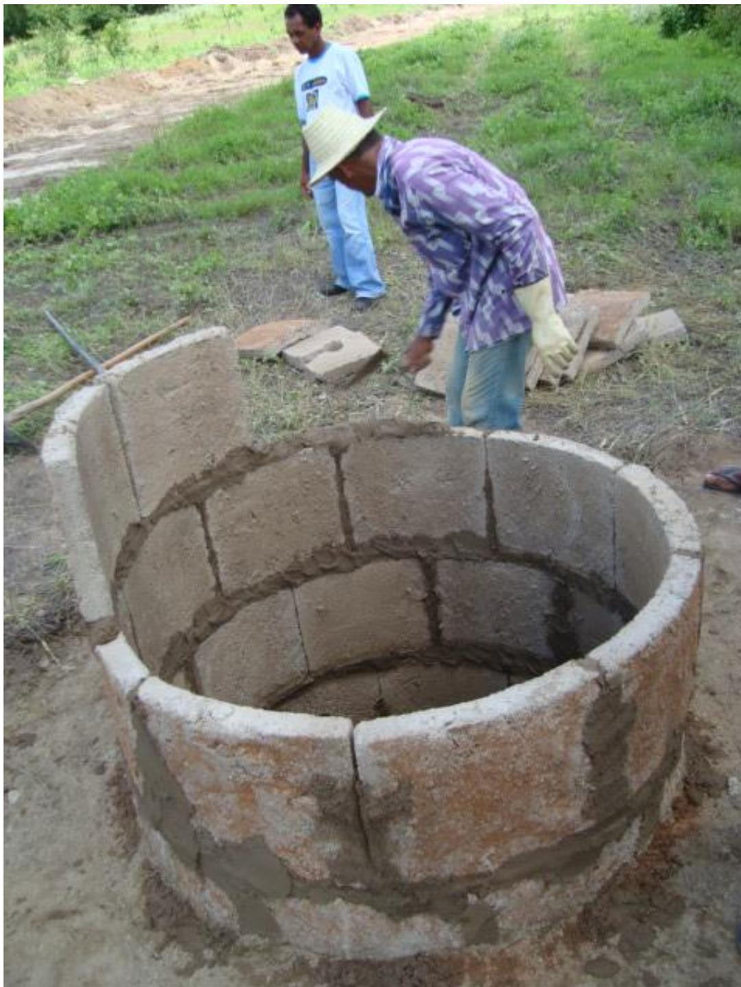
Figura 13: Instalação da caixa d'água
