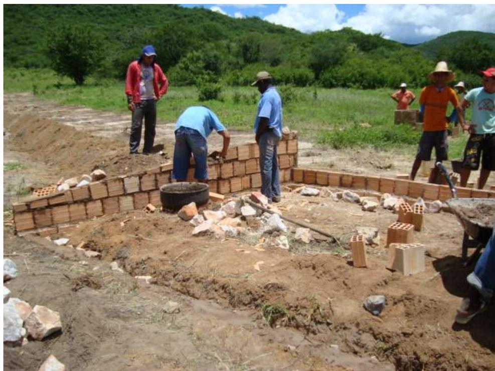
Figura 12: Construção do Poço (cacimbão)
