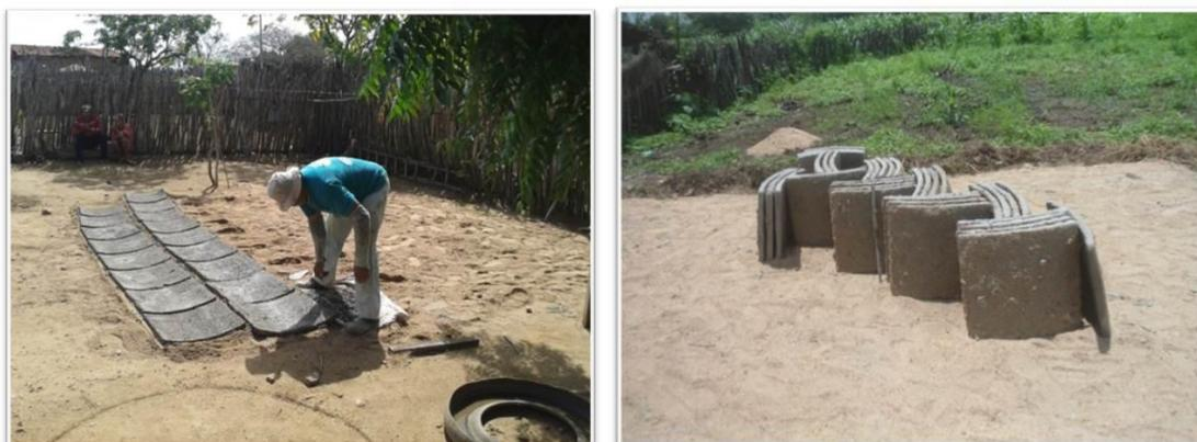
O piso do filtro deve ser executado com massa, tendo em vista que não haverá carga resultante da pressão de coluna de água. Após compactar e nivelar o fundo do buraco, faz-se a marcação do círculo onde será executado o piso do filtro, que deve ter pelo menos 1,60 m de diâmetro, pois as placas vão ficar apoiadas sobre esse fundo.
