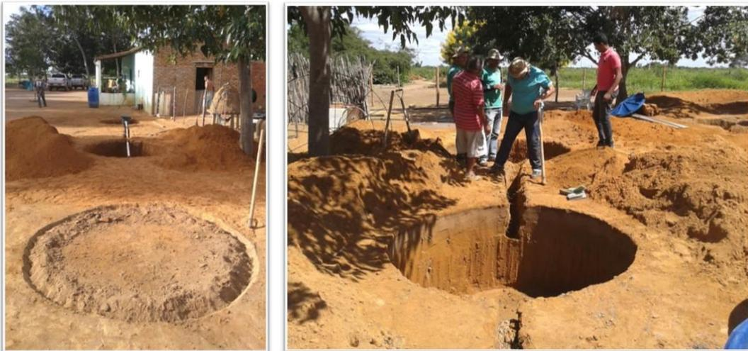
O filtro é confeccionado com duas fileiras de placas de cimento de 50 cm x 50 cm, com diâmetro de 1,5 metros e montado com nove placas por fileira, totalizando 18 placas. Por fim, faz-se a amarração das placas com arame galvanizado número 12, sendo rebocada tanto a parte interna como a parte externa.
