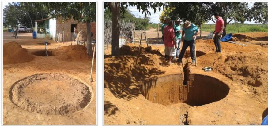
O tanque tem a função de armazenar a água de reuso oriunda do filtro, com capacidade de aproximadamente 880 litros, e deve ter a parte superior fechada para evitar que a incidência da luz solar permita a proliferação de algas, que alteram a qualidade da água e comprometem o sistema de bombeamento, além de evitar também possíveis acidentes e a proliferação de larvas de mosquito da dengue, dentre outros.
