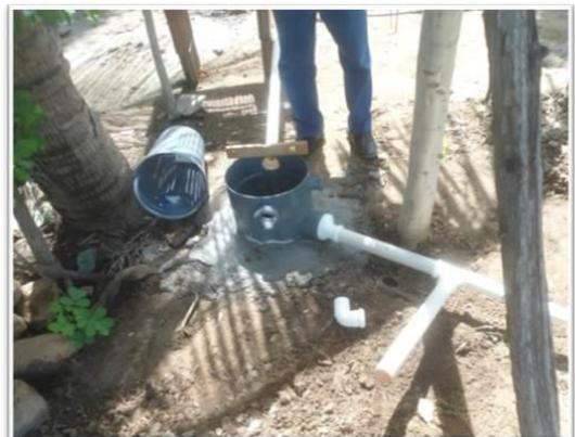
Importante também que seja utilizado um tubo de PVC DN 50 para descarga do excesso de água cinza produzida na residência, utilizando oara conectá-lo ao tubo de PVC um Tê de 50 mm. Além disso, utiliza-se um cap de 50 mm para fechar a saída de água.
