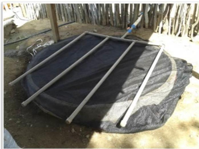
Nas extremidades de cada tubo de PVC deve-se conectar CAP de 32 mm.
