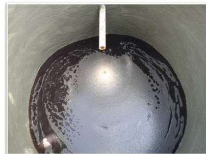
O fundo do tanque de reuso deve ser estruturado com uma grade de ferro e argamassa. A grade deve ser feita com ferros de 1/4. A grade é colocada em cima de uma camada de argamassa de 3 centímetros de altura. Depois ela é coberta com mais 3 centímetros de argamassa. Devendo ficar com pelo menos 6 cm de altura.
